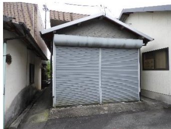
▲⑪消防倉庫
