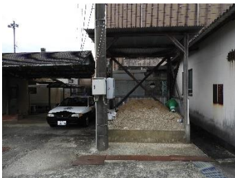
▲⑬防災砂場及び車庫
