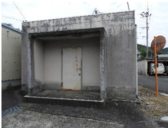
▲⑦耐火倉庫
