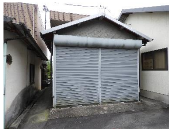
▲⑪消防倉庫
