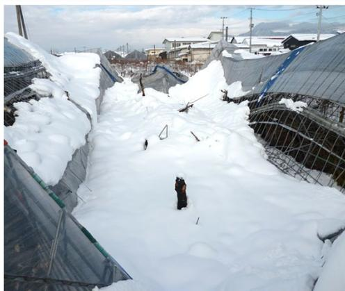
補強未対策によるハウスの倒壊
