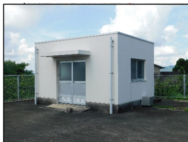
49 南部第1配水池
