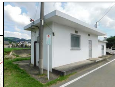
37 北部第1水源地ポンプ室
