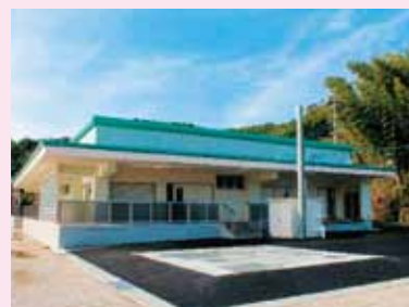
▲玉東中学校敷地内に建設された共同調理場(床面積378㎡)
