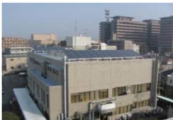
太陽光発電（上下水道局別館）
