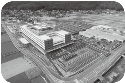
正面玄関東からの全景
