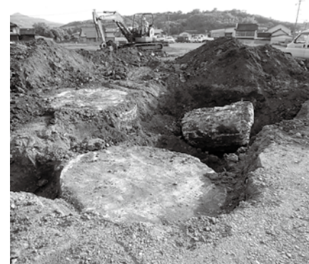
シルクタウン造成中に出土した基礎の一部
