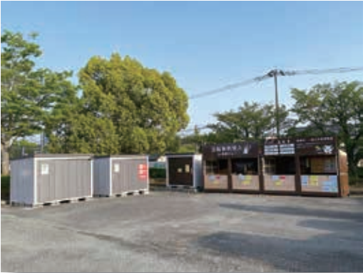
▲ 役場敷地内に設置されたりサイクルBOX
