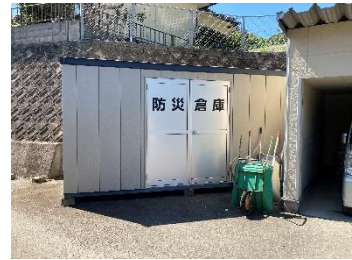
▲⑨防災倉庫
